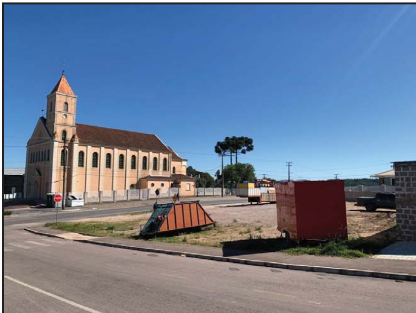
Foto 3 – Frente para a rua Rui Barbosa
