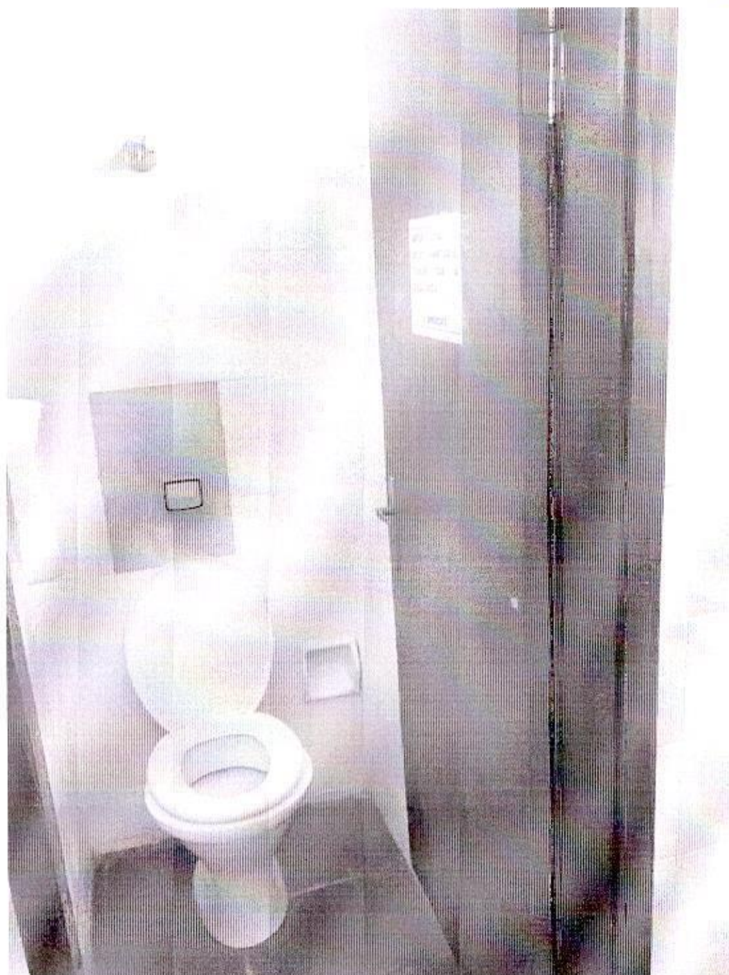
Figura 42: Banheiro piso superior.
