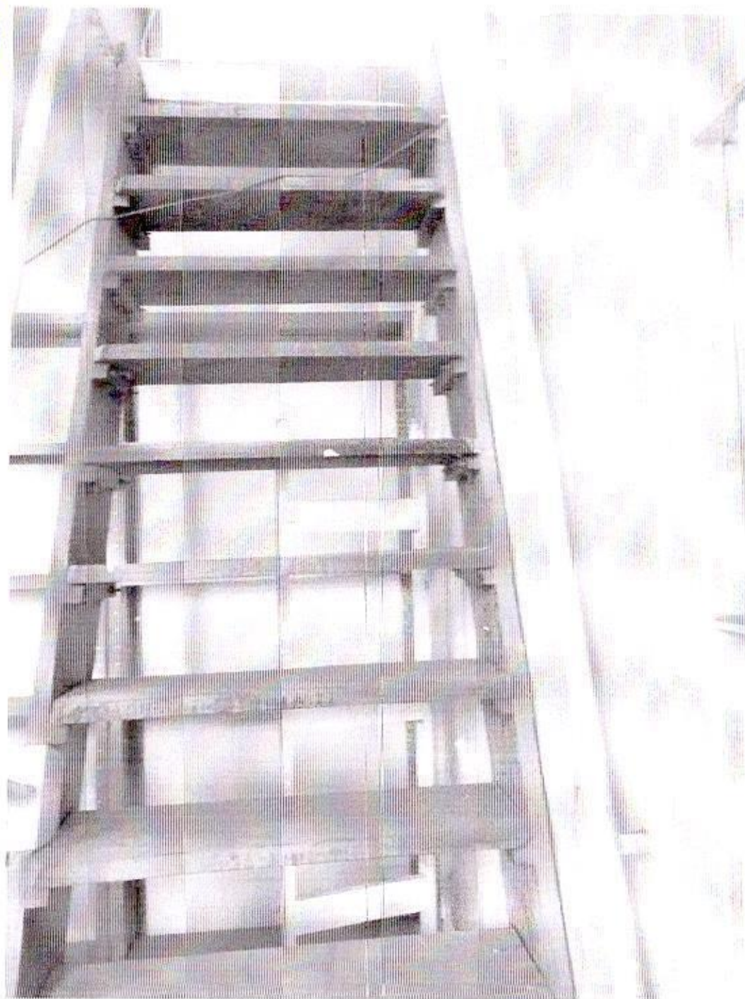
Figura 23: Escada de acesso a Sala de Armas.
