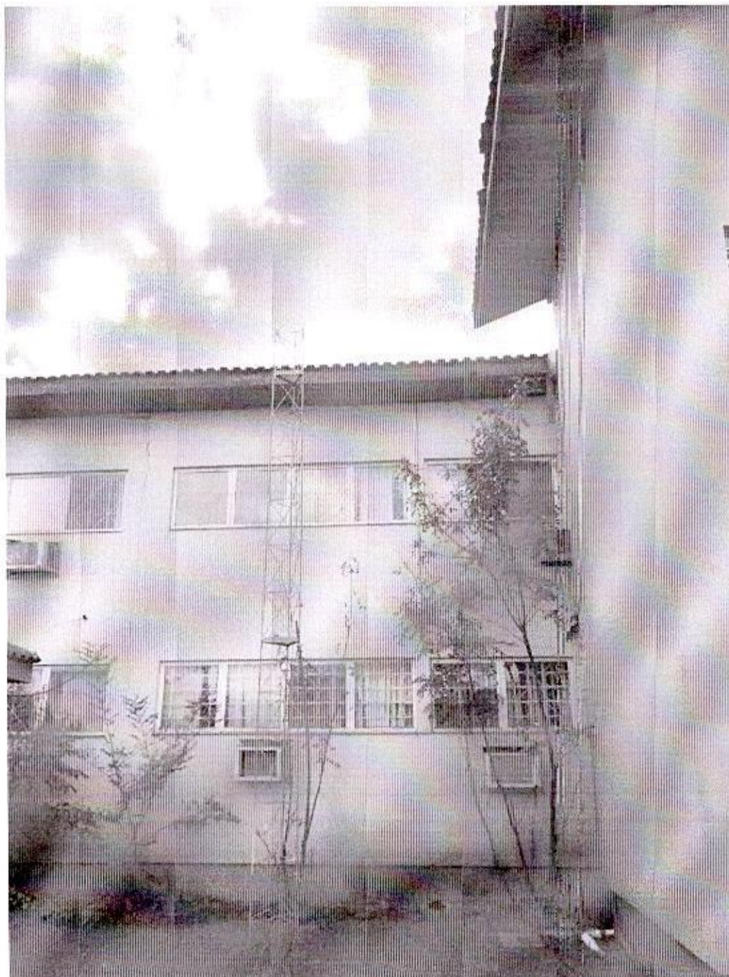
Figura 54: Área externa do antigo Fórum.
